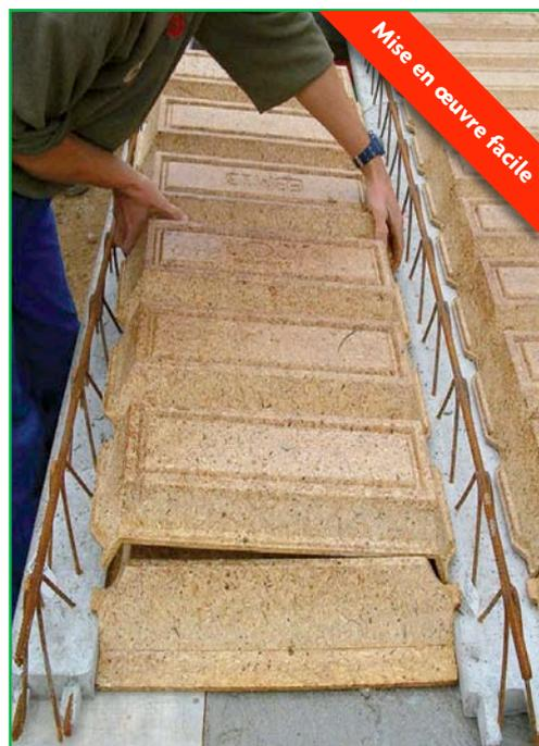
Mise en place facile, les abouts réglables coffrent parfaitement l'extrémité des travées.
