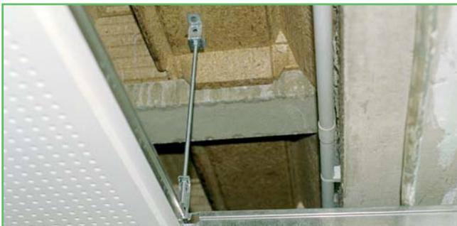
La suspente OMEGA peut se fixer sur la totalité de la sous-face de l'EBM.
