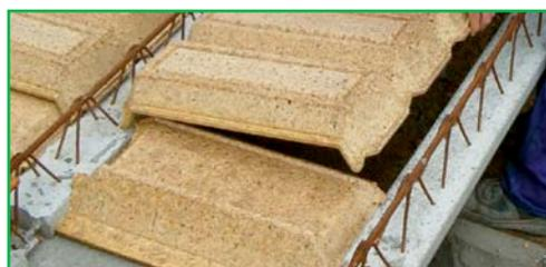
EBM-A permet d'adapter la longueur des entrevous EBM 13 ou 16 à la longueur exacte de la travée.
