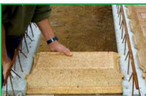
Sa légèreté se traduit par une mise en œuvre facile et rapide du plancher : une palette de 630 Kg (120 pièces) permet la réalisation d'un plancher de 87 m<sup>2</sup>. Les nervures transversales assurent une grande rigidité et permettent une découpe facile à la main, sans aucun outil. L'about EBM-A, commun aux entrevois de 13 et 16 cm, garantit une parfaite jonction avec les murs et élimine tout rebus grâce à son système de réglage breveté.
