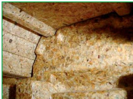
Vue en sous-face d'un EBM 13 et d'un EBM-AL.
